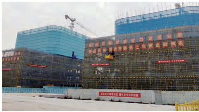
连日来,由产业发展公司承建的自贸区重点项目——连云港医药创新产业园抢抓当前施工有利时机,全力攻坚突破,力争夺秒加快重大项目建设推进,全力以赴夺取首季“开门红”。(顾卫远)
